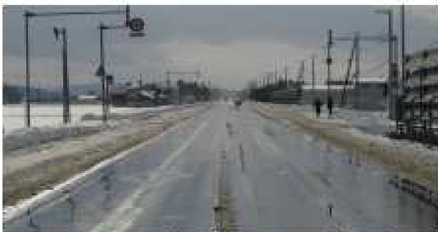
湿潤、凍結した道路
