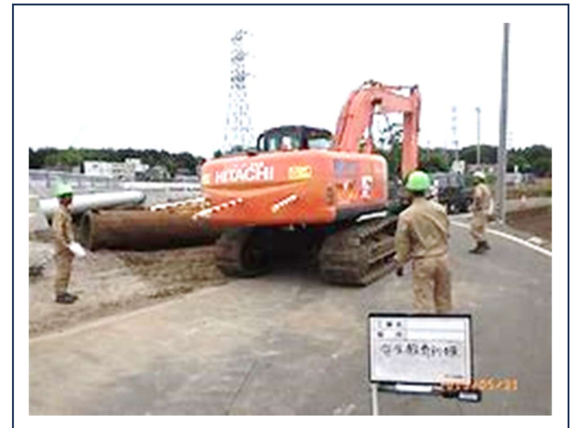
重機の死角にも注意
